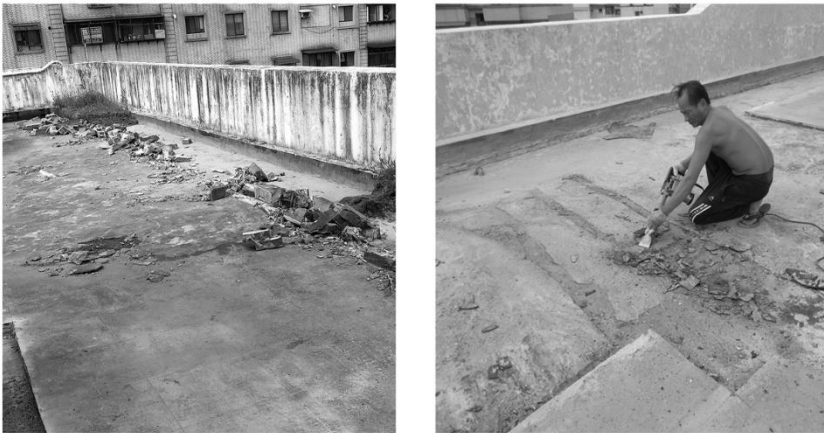
屋頂平台修復工程照片
